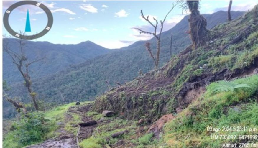
FOTOGRAFIA N°03: Se evidencia del cierre del acceso principal
